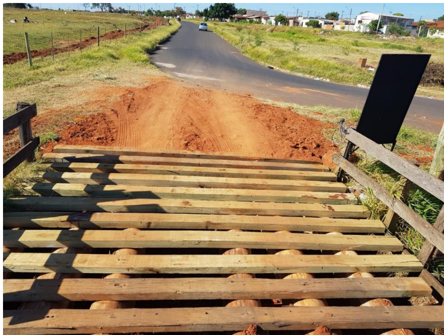
Figura 6.14. Mata-burro de madeira na entrada de estrada vicinal a partir de uma rodovia.
